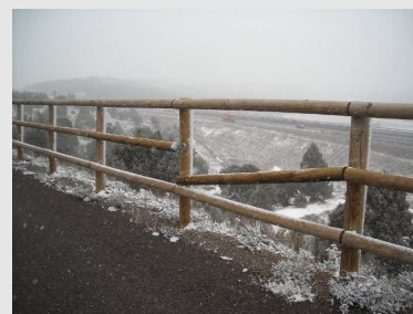
Reposición tramos de barandilla
